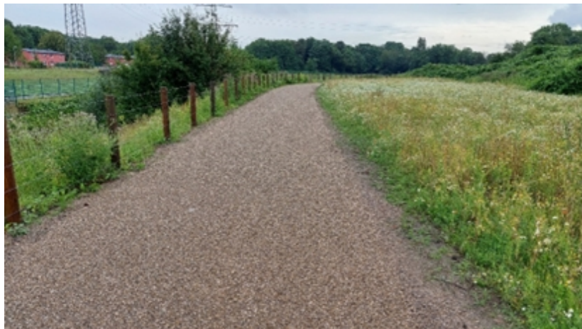
Abb. 1: Asphaltweg mit hellem Splittüberwurf
